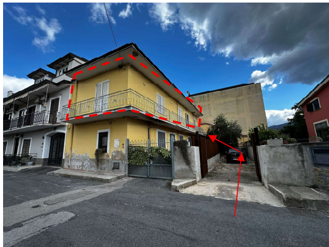
Prospetto su Via Trieste
